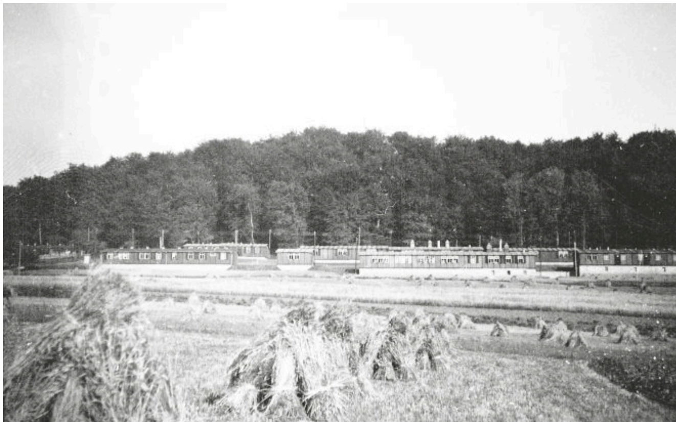
Bléck op d'Schraasseger Lager vun der Schëtter Strooss erop. Gutt ze erkennen d'Zuel vun de Module pro Brak an d'Fënsteren am Sockel bei de fischte Brake riets. (Foto LUX1941, RAD-Abtg. K3/240, Blick auf Baracken in Schüttringen (MB)21136) (Archiv CV).
