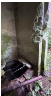
Opmaten aus dem Waasserhaischen (Foto S. 17): e Waasserschacht mat futtissem Bëtongs-Deckel an eisen Träppleken, vun der Quell gespeist; en Emplacement am Buedem wou eventuell eng Pompel stoung, déi d'Waasser erop an d'Réier gespeist huet. (Archiv CV)
