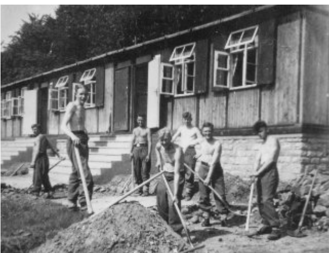
RAD-Lager Schraasseg - Gutt ze erkennen, wéi d'Brak op enger Bëtongsdall stoung, déi vu stenge Mauere gedroe war an och déi typesch Trappen, di charakteristesche norméiert Fënsteren an Dieren. (Archiv M. Folschette)
