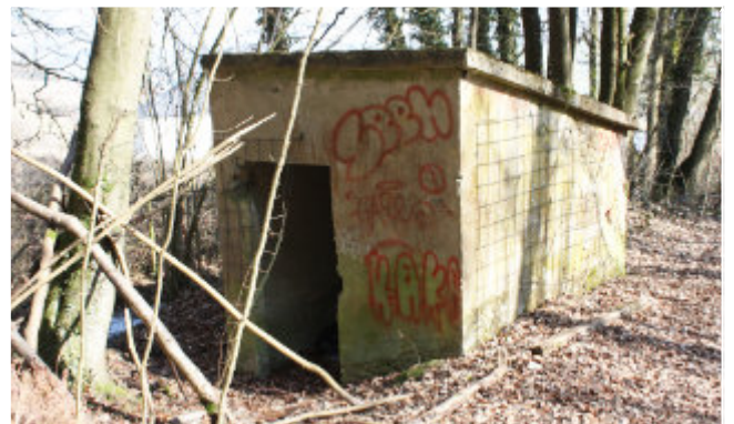
Waasserhaischen, an deem d'Quellewaasser warscheinlech op den néidegen Niveau gepompt gouf, fir et dann duerch ierde Réier bis an d'Lager ze leeden. (Archiv MT)
